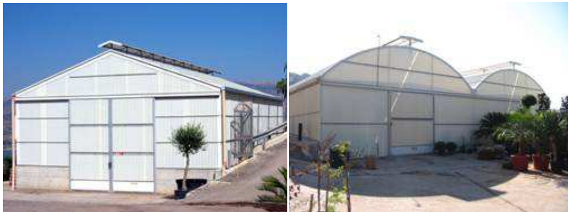
Slika 34: Različni tipi vrat na rastlinjakih in različen tip prezračevanja (IOC, 2008).
